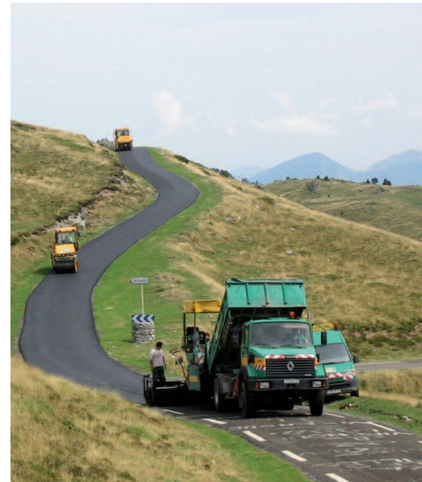
Reprofilage de chaussées (débombement ou déflachage).
