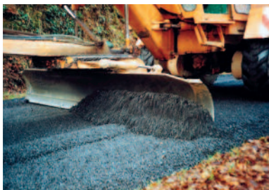
Reprofilage à la niveleuse.
