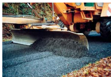
Reprofilage à la niveleuse.
